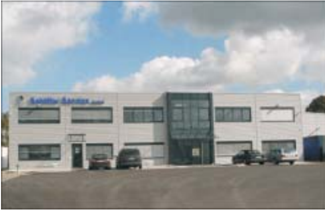
In nur drei Monaten entstand an der Industriestraße die neue Betriebsstätte der Schiffer Service GmbH. Foto: Küppers
